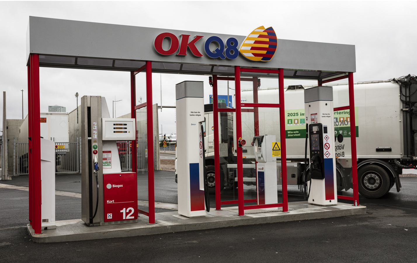
OKQ8:s nya vätgasstation för tung trafik vid Falutorget i Göteborg. Den ska kunna leverera upp till 1500 kilo grön vätgas per dygn, vilket uppges räcka till cirka 20 tunga lastbilar.
