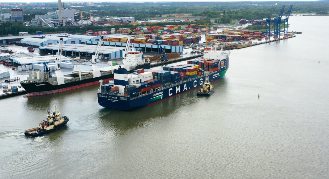
Fartyg på väg in till Norrköpings hamn. Bolaget har varslat om att de planerar att säga upp elva hamnarbetare.
