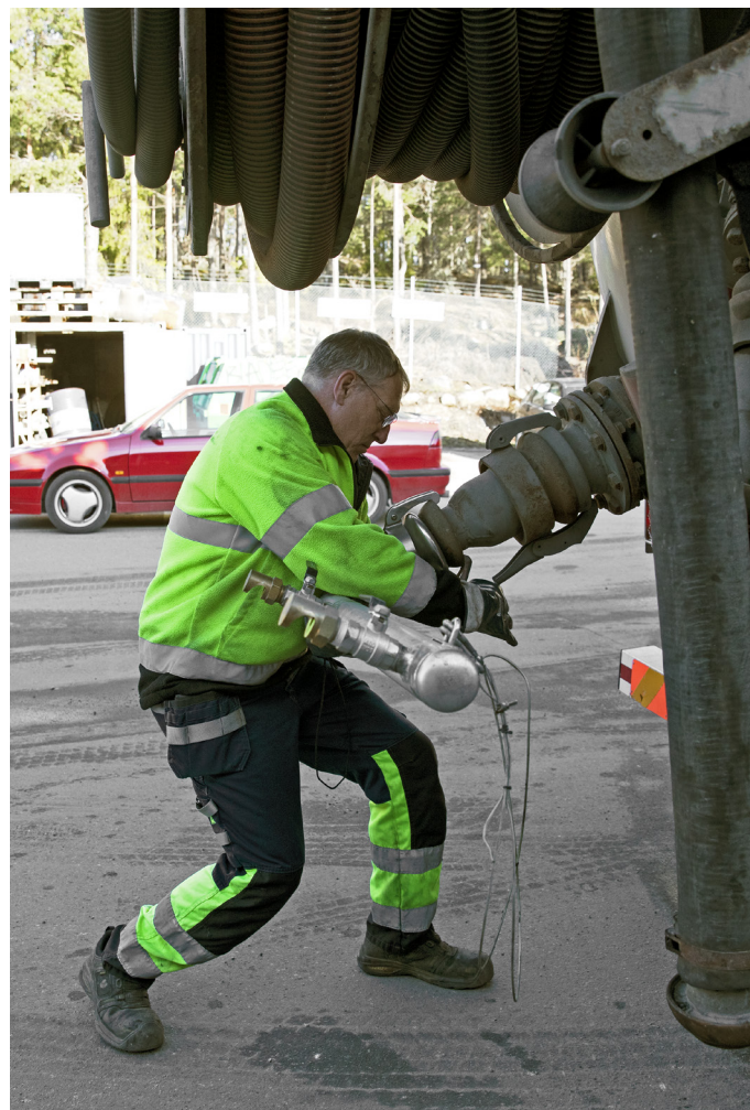
Jimmy Söderström ser till att rampen för att spruta dammbindande dustex kommer på plats bakom slambilen.
