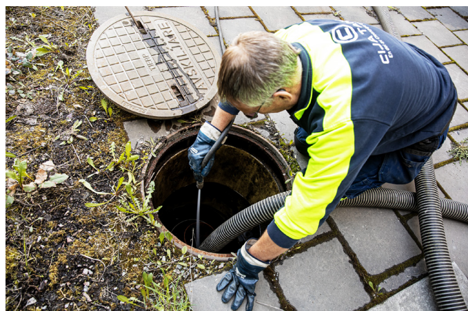
Jimmy kontrollerar, tömmer och spolar en oljeavskiljare.
