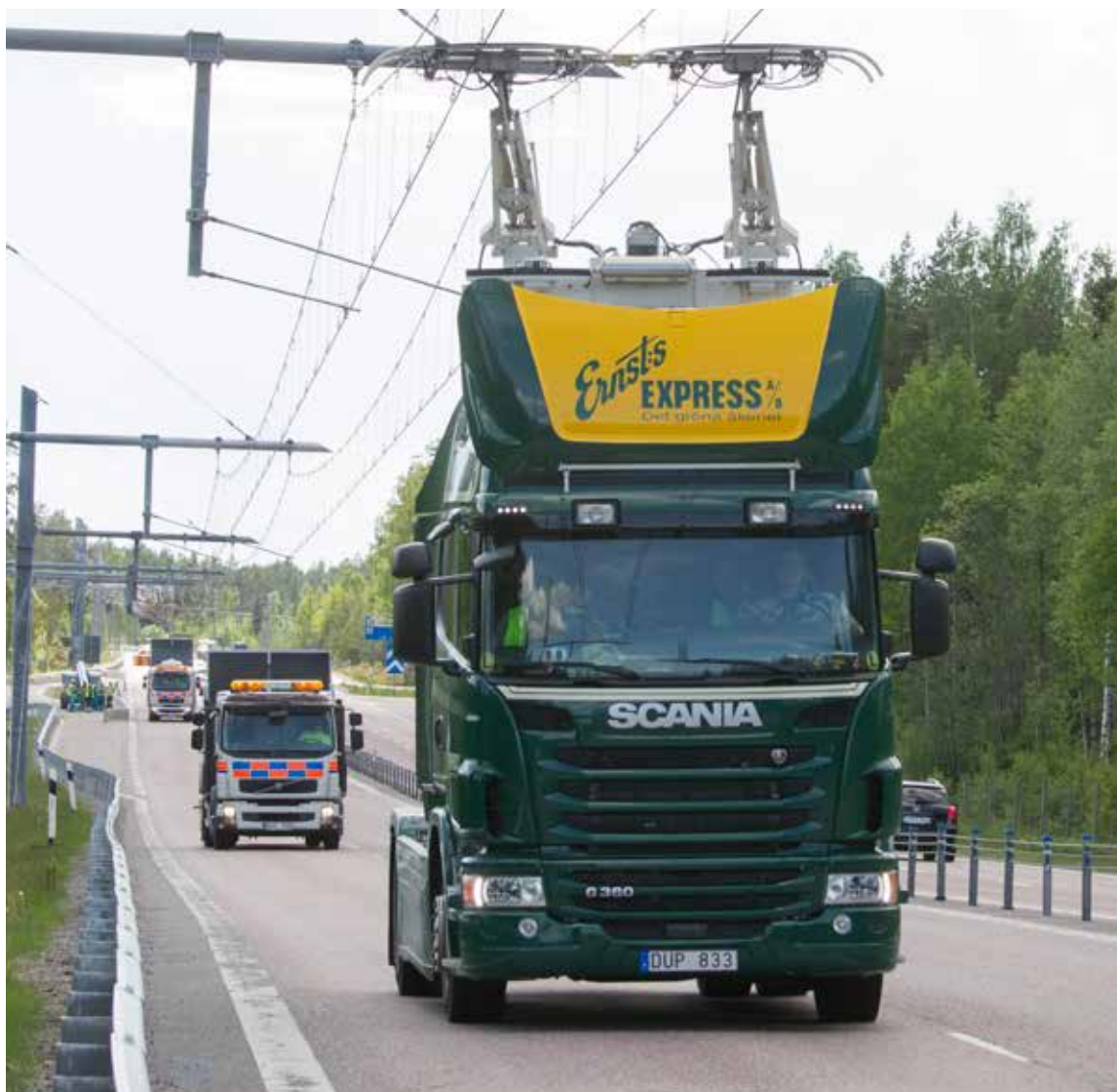
Utanför Sandviken pågår ett försök med lastbilar som drivs med el från lufttrådar. Vid omkörningar eller viadukter kopplas strömvtagaren automatiskt ner och bilens dieselmotor går i gång.
